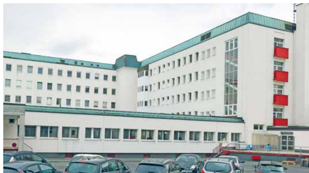
Die Bausubstanz der Kreisklinik - unser Foto zeigt den Betten- und OP-Trakt von der Westseite - ist gut. Sanierungs-Maßnahmen sind hier nicht notwendig. Foto: pem
